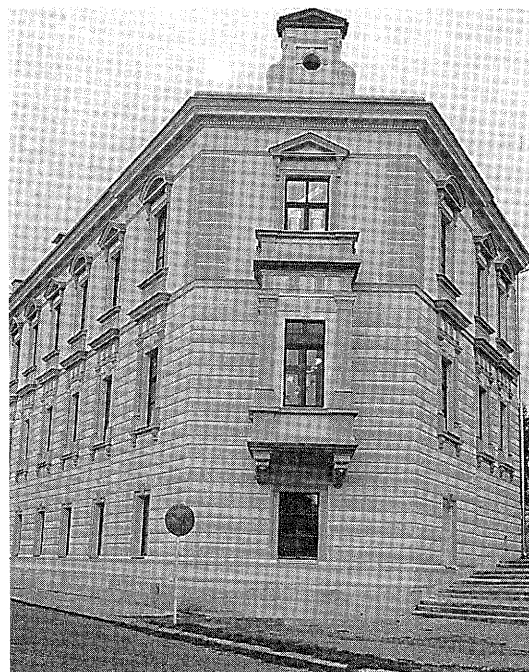
Jihovýchodní část historické budovy divadla už září obnovenou omítkou Foto J. Prokop
