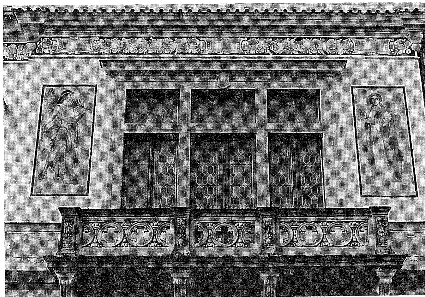
Detail z obnovené výzdoby na novorenesanční budově Okresního domu Foto J. Prokop
