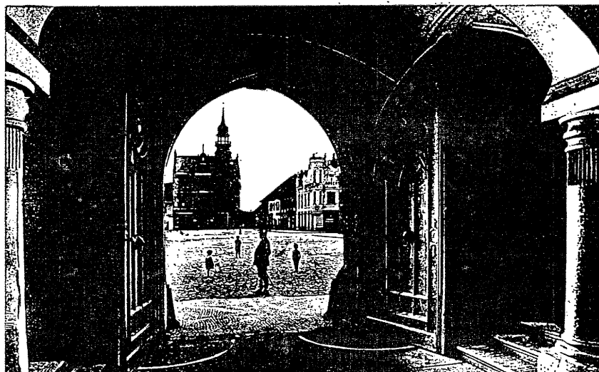
Nový Bydžov. Partie z vestibulu radničního.
