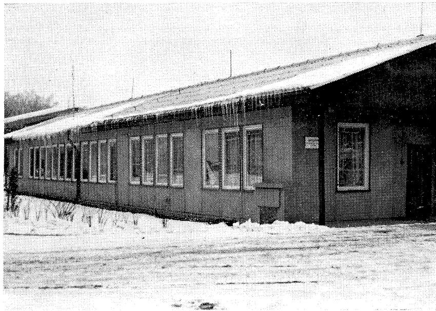
Novostavba sociálního zařízení a kanceláří
