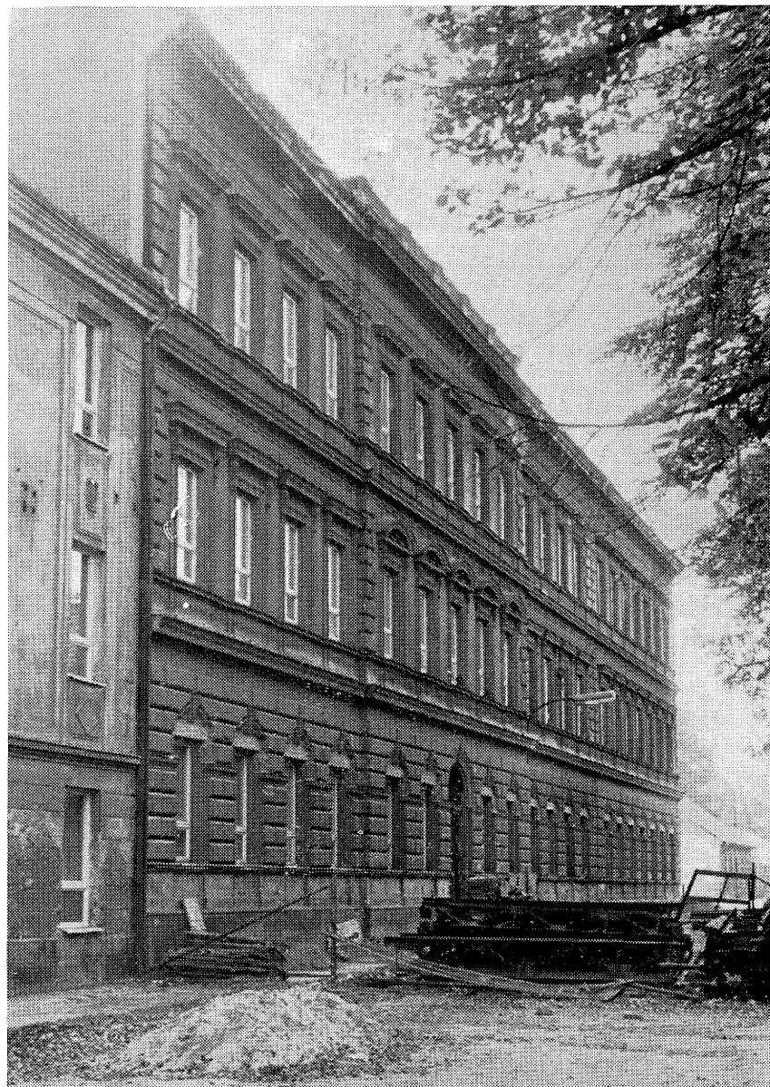
Průčelí budovy gymnázia bezprostředně před novou úpravou
