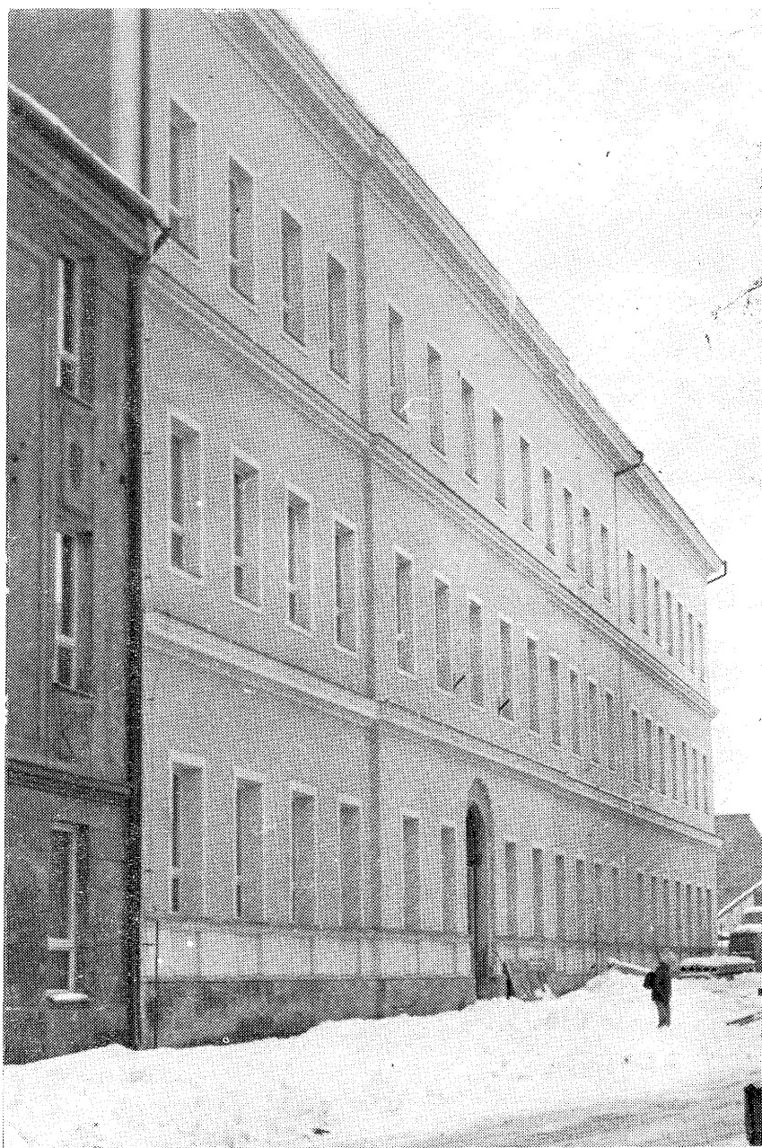
Nově upravené průčelí gymnázia koncem roku 1980
