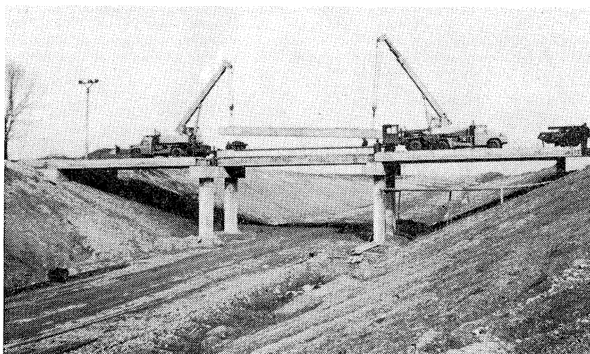
Zemní práce a montáž třípolového mostu nadjezdu u Činěvsi na Nymbursku
