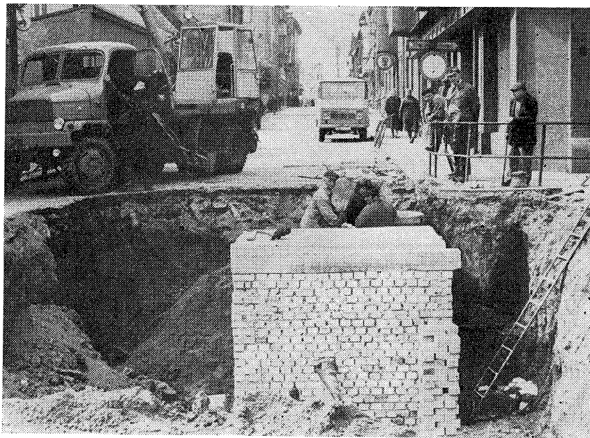
Pohled na stavbu rozvodné šachty v křižovatce před restaurací U Stehlíků FOTO M. BYDŽOVSKÝ
