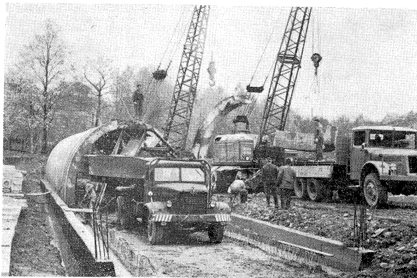
Montáž parabolických mostních prvků na Pitkovickém potoce u Řičan
