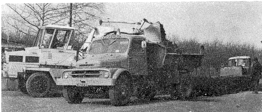
Zapojení těžkých mechanizačních strojů do výstavby parkoviště automobilů u nemocnice
