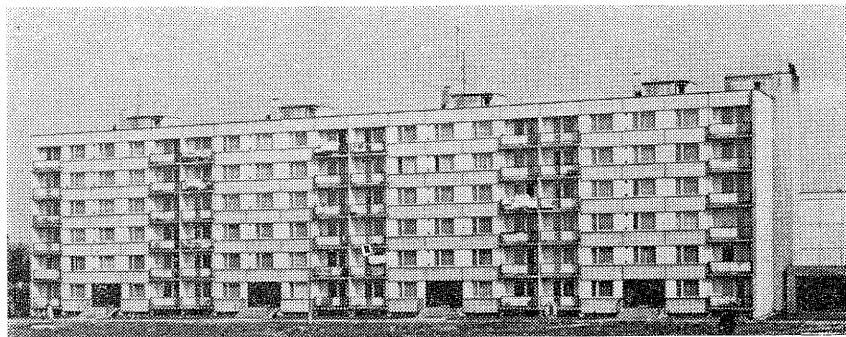
Moderní panelový dům za sokolovnou
