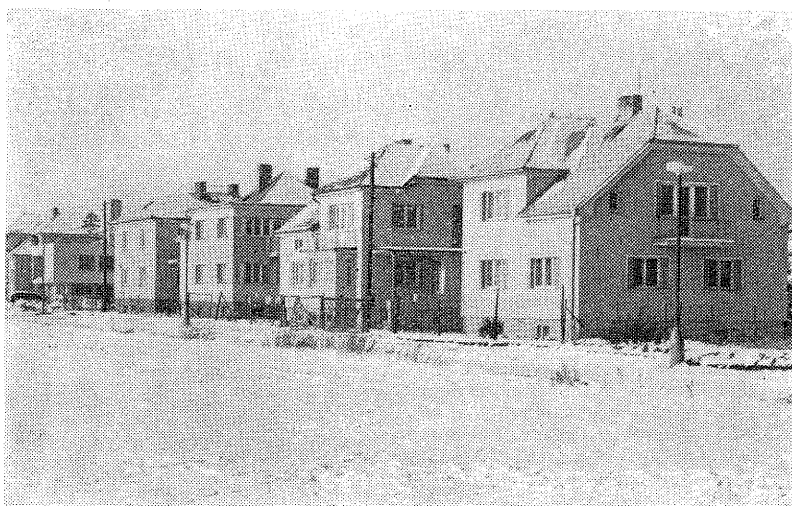
Výstavba rodinných domků u hřbitova. Foto J. Prokop
